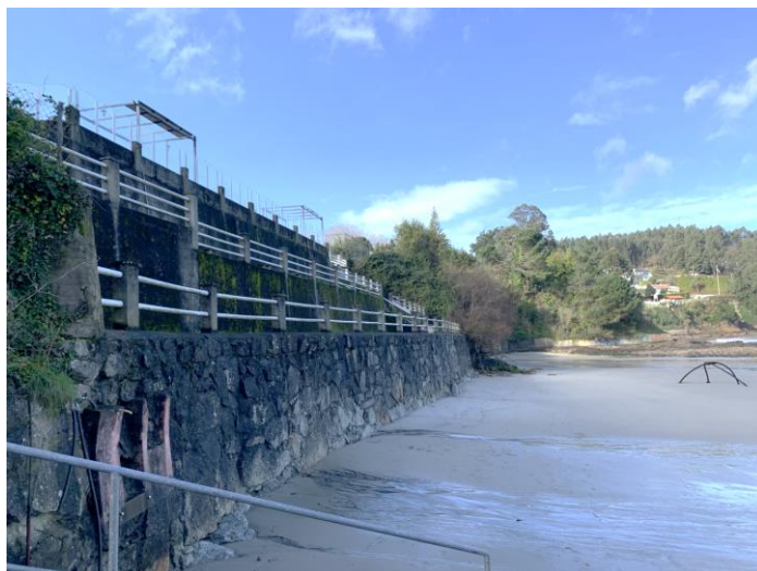
Muro de contención na praia de Cirro
